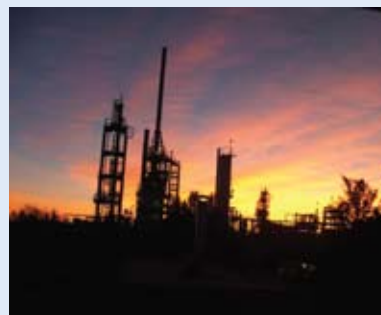
Planta de TDI de PRIII, Río Tercero, Córdoba
